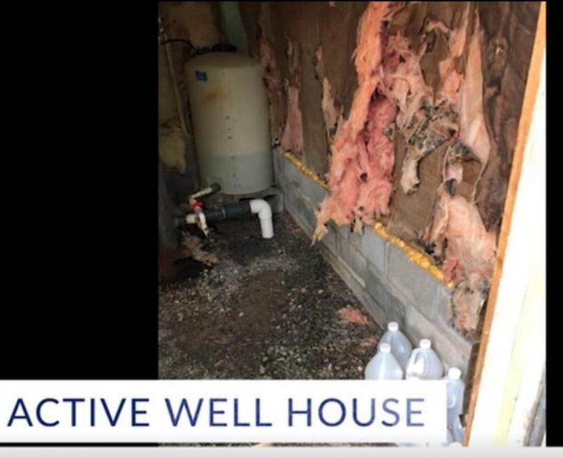
STATUS: INSULATION DAMAGED, CHLORINE IN SAME ROOM AS STORAGE
