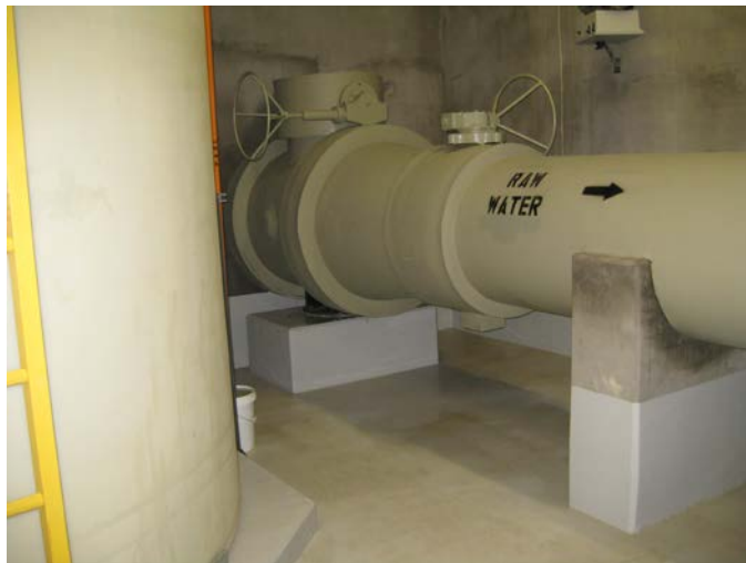
Raw Water Mag Meter
