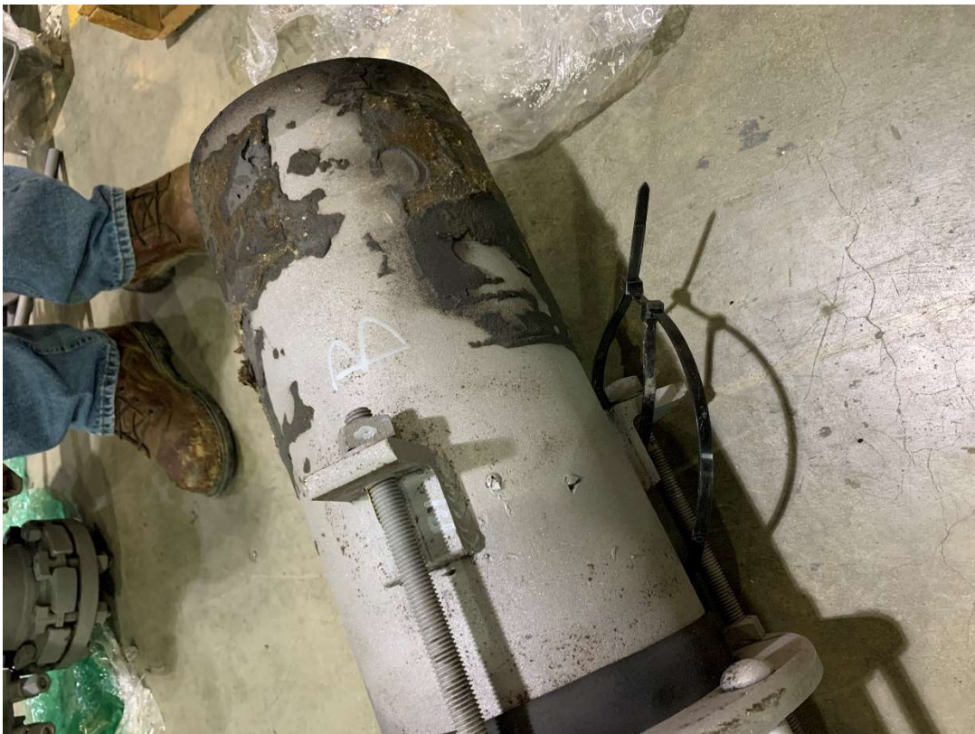
Figure 6 Pipe B, Lug B1
