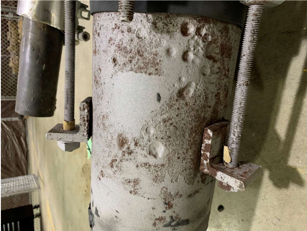
Figure 5 Pipe A, Lug A2 and A3
