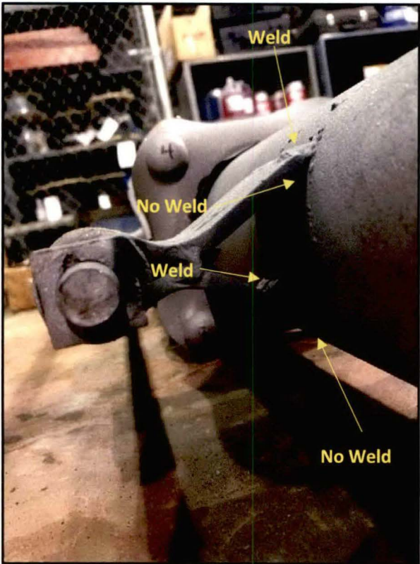
Figure 11- Lug A1 Welds
